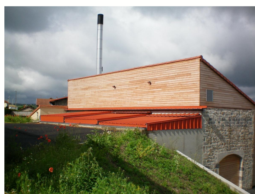
Chaufferie communale à bois déchiqueté (P. Merz)
