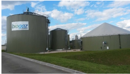
Unité de méthanisation : Biogaz de Gaillon (27)
