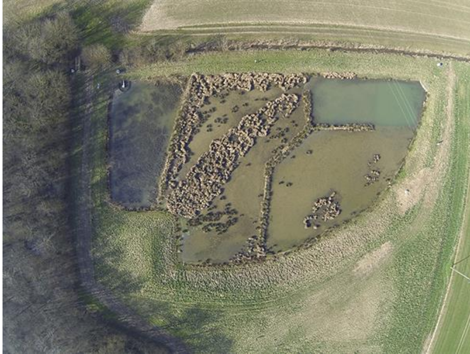
Photographie 1 - Dispositif collectif du bassin de Rampillon (Île-de-France)
