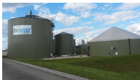
Unité de méthanisation : Biogaz de Gailfont(27)
